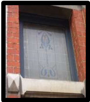
Baie d'imposte ornée d'un vitrail déco
